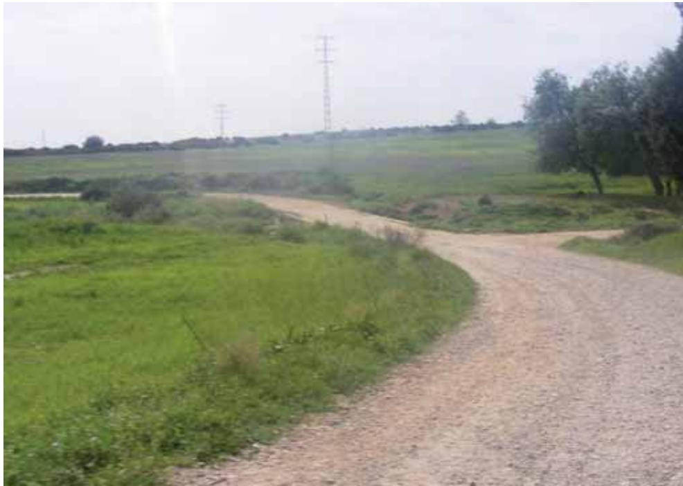
Foto 192: Camino a la derecha particular y puente sobre arroyo
