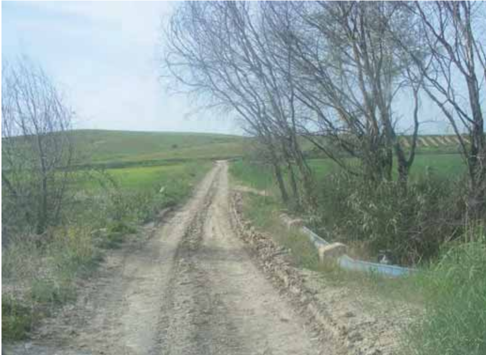
Foto 202 : Paso de arroyo por puente
