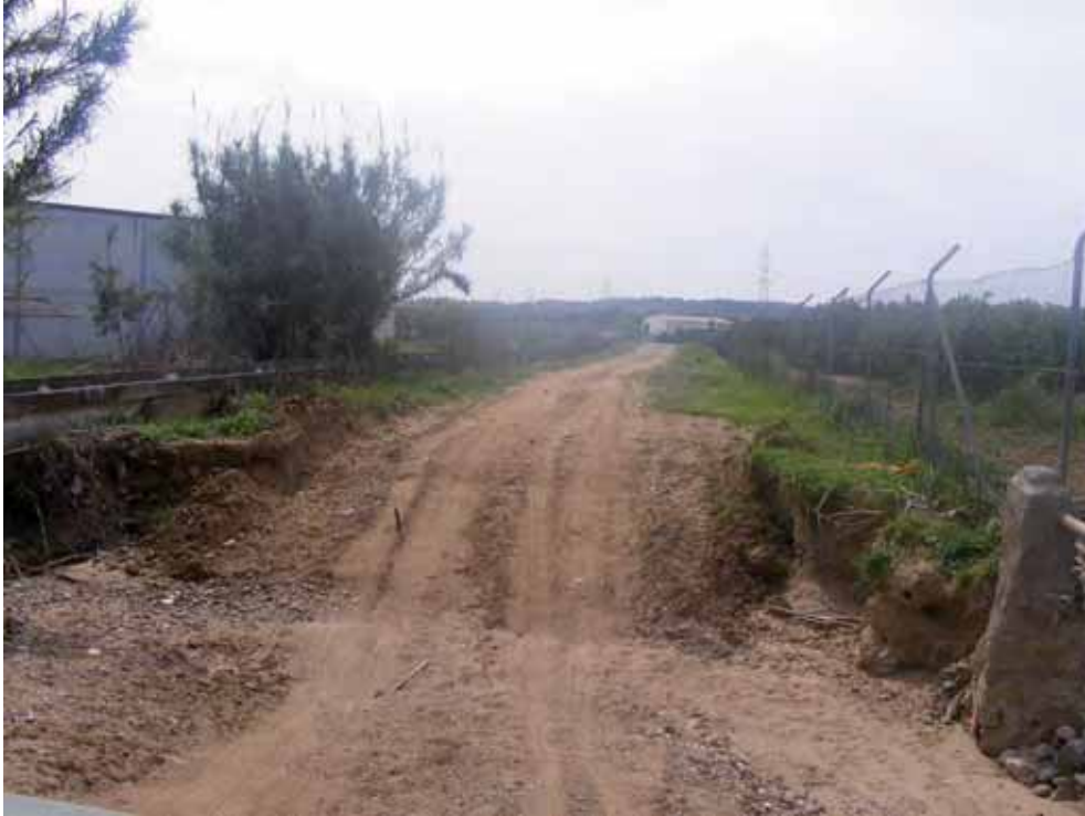
Foto 190: Vado sin asfalto con difícil pendiente
