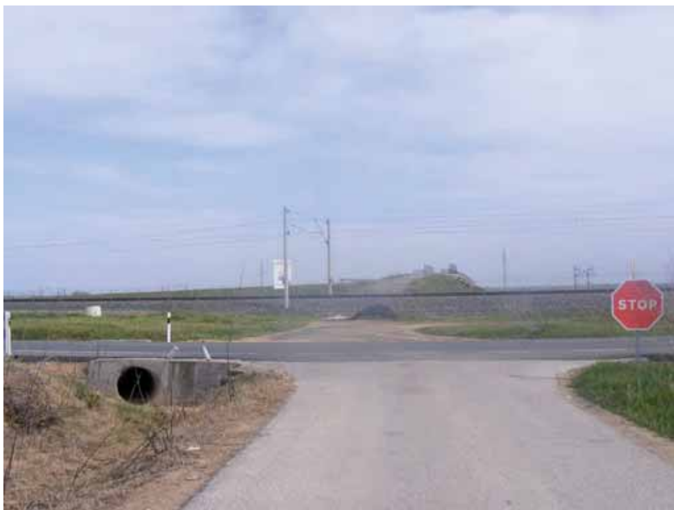
Foto 199 : Cruce con carretera A-341 en el Km. 5,10
