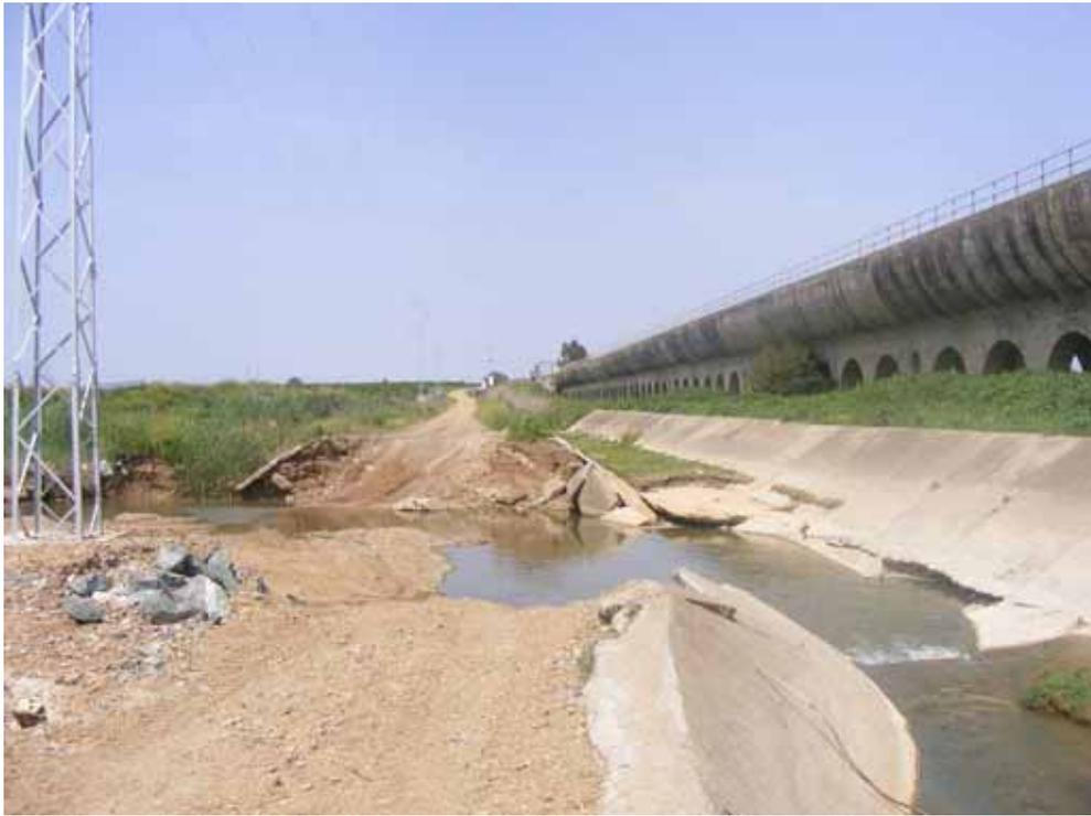
Foto 13 : Vado en mal estado con excesiva pendiente
