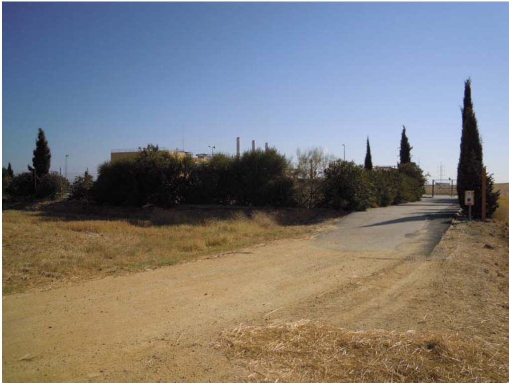
Foto 64 : Edificio de transformación de la Planta solar a nuestra Derecha
