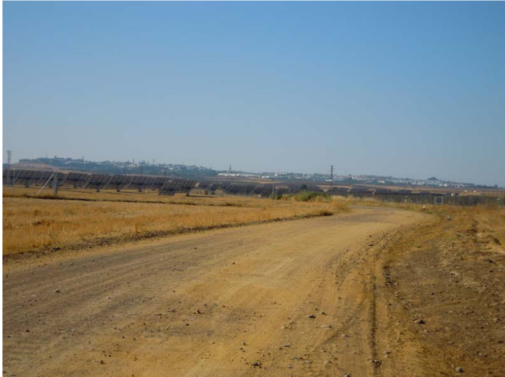
Foto 62: Vista de la Planta Solar
