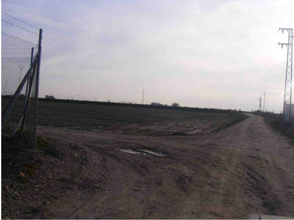
Foto 29 Cruce en el Km. 3,90
