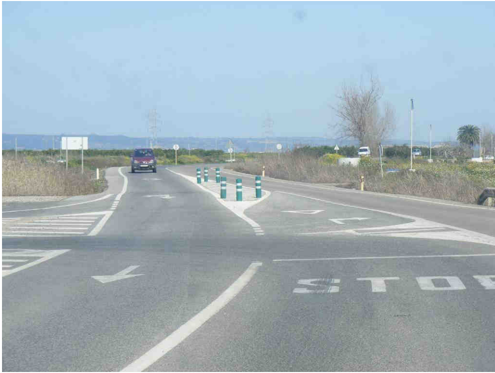
Foto 35: Cruce carretera en el Km. 9.50 (d)
